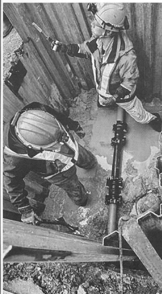
富山市組合による復旧工事(七尾市)
